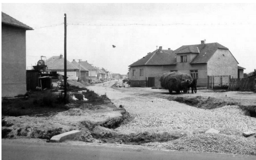
Budovanie Kollárovej ulice
