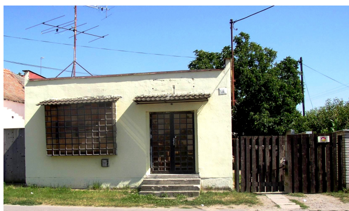
Budova bývalej Opravovne obuvi dnes
