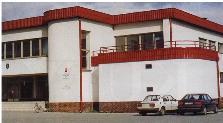
Budova obecného úradu dnes
