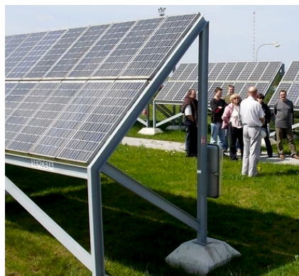
Fotovoltaická elektráreň pri jadrovej elektrárni Dukovany
