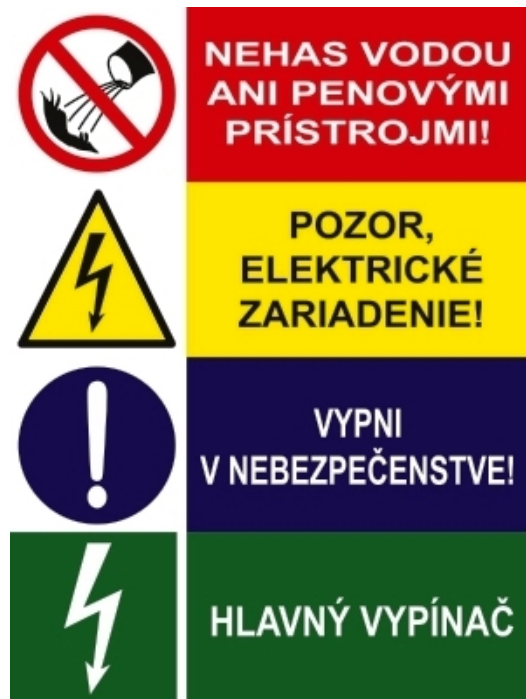
Obr. 6 Na rozvádzačoch nesmú chýbať bezpečnostné označenia
