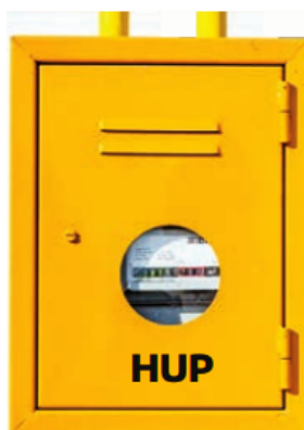
Skrinka hlavného uzáveru plynu s plynomerom
