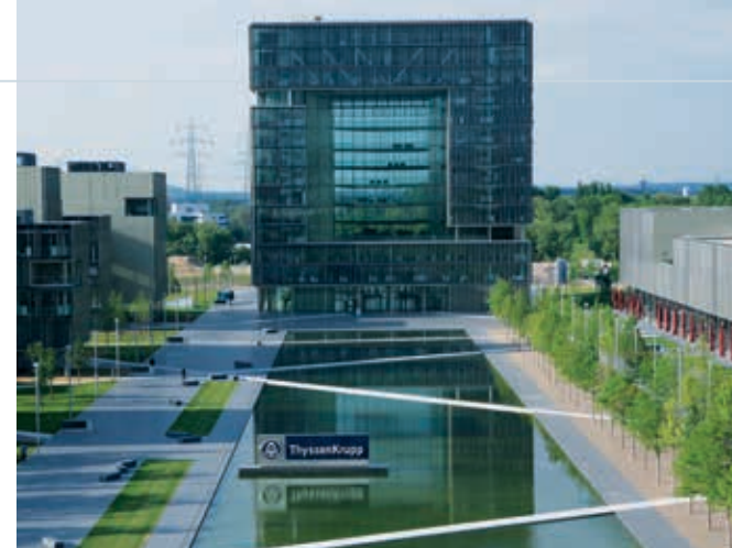
Centrála ThyssenKrupp v Essene: Novému sídlu globálnej spoločnosti dodal Siemens komplexné riešenie pre automatizáciu budovy.
